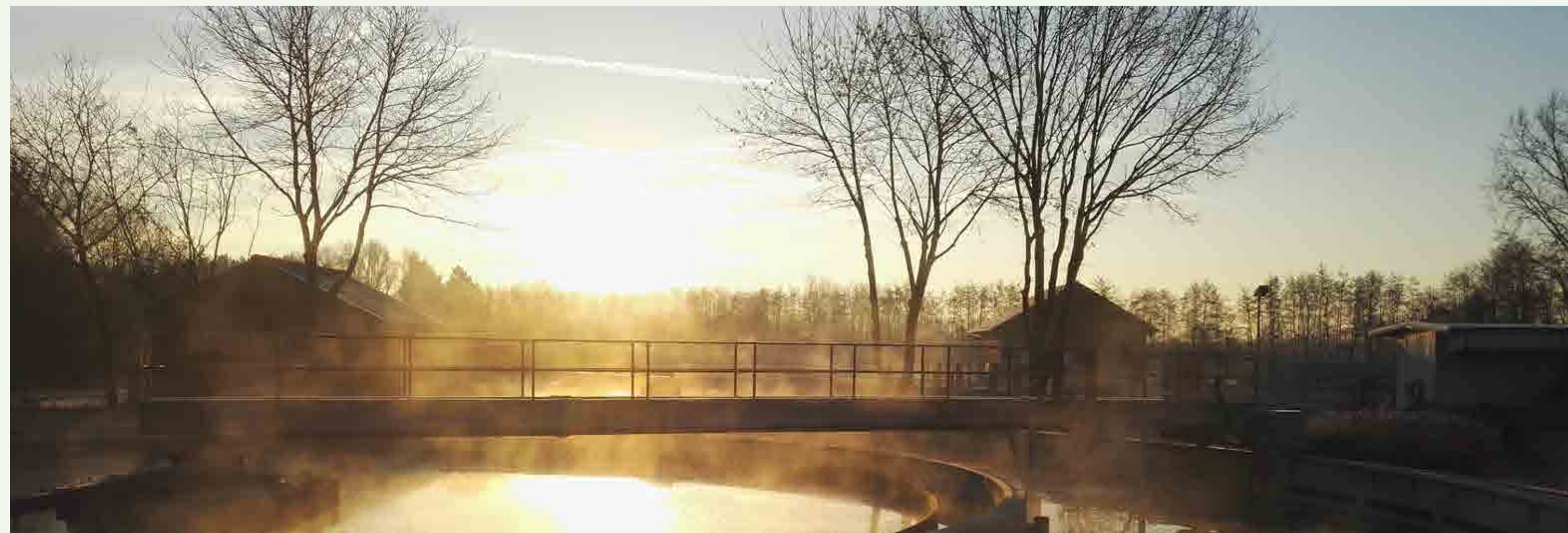
Foto: ©Dirk Ottensmeier Kläranlage im Nebel, DWA Fotowettbewerb
