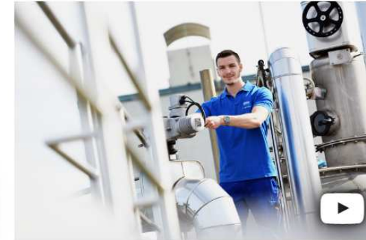
ELEKTRONIKER*IN FÜR BETRIEBSTECHNIK
