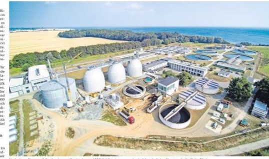
Nach einem Stromausfall gelangten am Montag knapp 4000 Kubikmeter nur mechanisch behandeltes Abwasser in die Kieler Förde.
